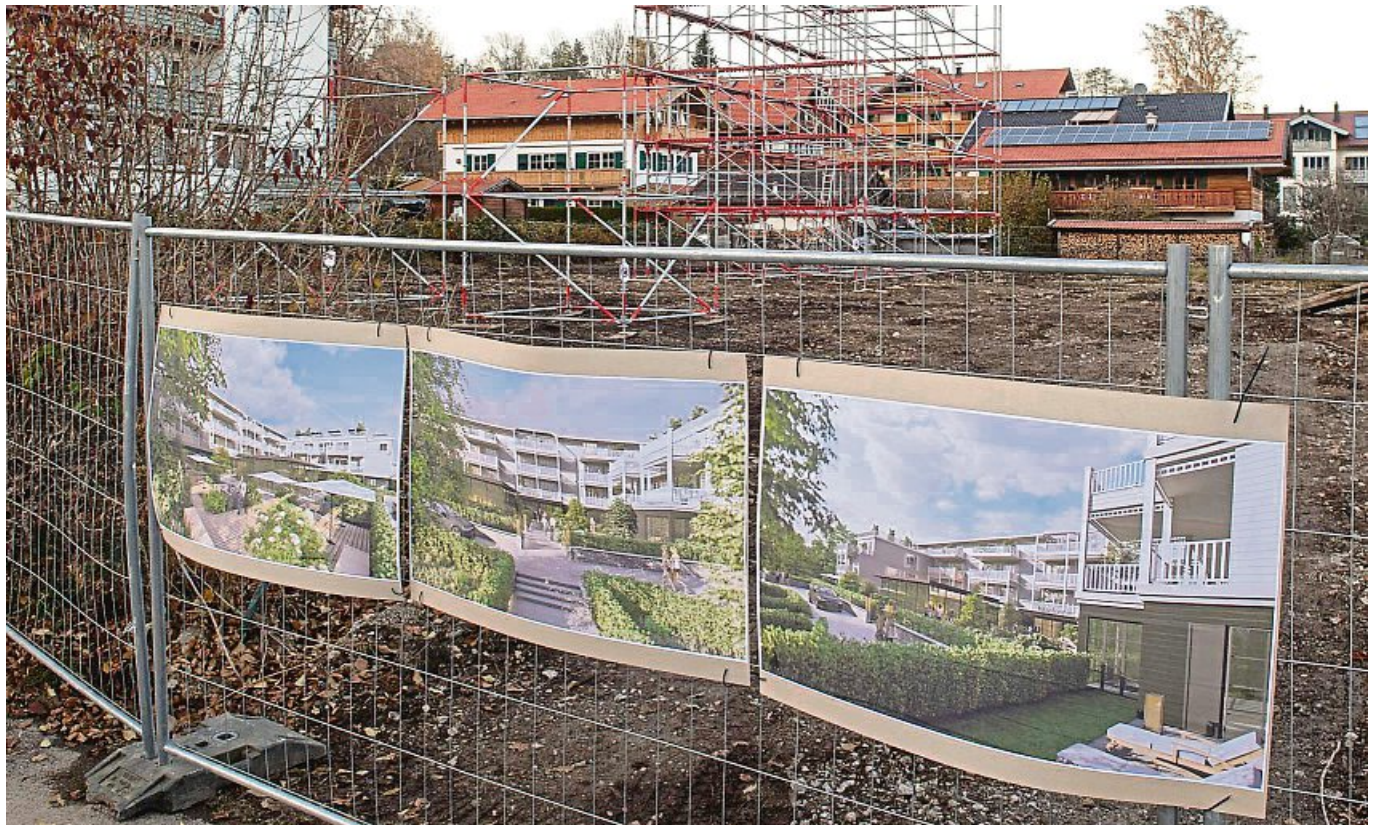
Ein von der Gemeinde gefordertes Baugerüst und Visualisierungen vermittelten den Wiesseern kürzlich einen Eindruck vom geplanten Barefoot-Hotel, das an der Hirschbergstraße entstehen soll. FOTO: THOMAS PLETTENBERG
